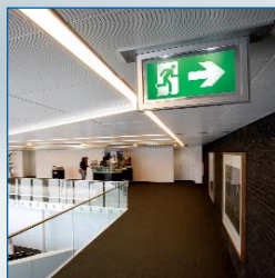
Pose plafond encastré
