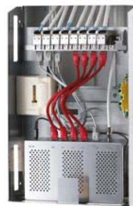
COFRACOM G3 Coffret de communication Grade 3 : reconnaissance automatique du signal
