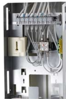
COFRACOM G1 Coffret de communication Grade 1 : brassage manuel
