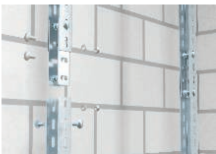
Eclissage des montants en U
