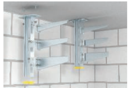
Montage de 3 niveaux de chemins de câbles avec les consoles type AS 15, AS 30 et AS 55 sur plafond béton.
