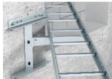
Montage d'une console adaptable pour chemins de câbles dans des angles difficiles.
