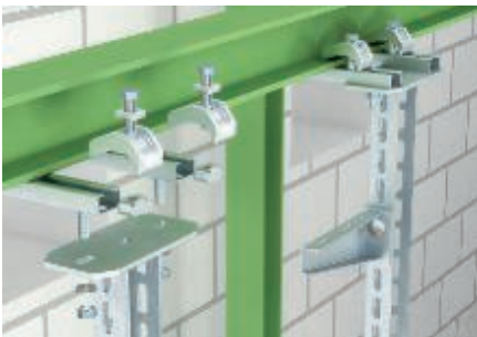
Montage de deux rails en C sur IPN
