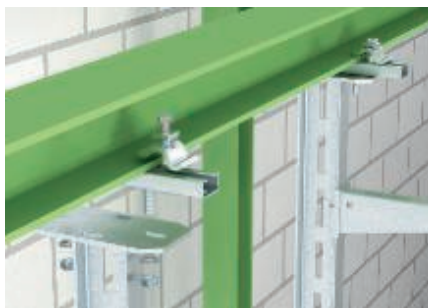
Montage des pendants sur IPN avec les crapauds de serrage.
