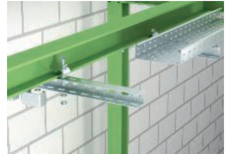
Montage d'un montant en U sur IPN
