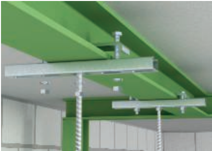
Montage avec un rail en C sur IPN
