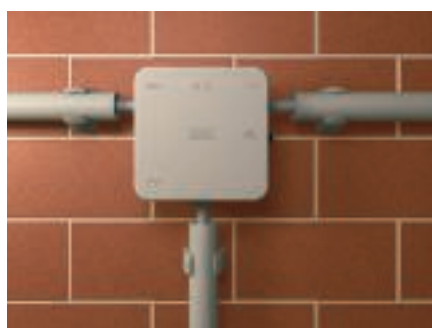
Montage et installation de la boîte de dérivation type A11 terminés avec des tubes Quick-Pipe et colliers OBO Quick 2955.
