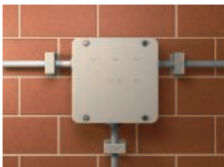
Montage terminé d'une boîte de dérivation en Duroplast avec embouts à têtine emboîtables type EDKS et colliers à pression isolants.
